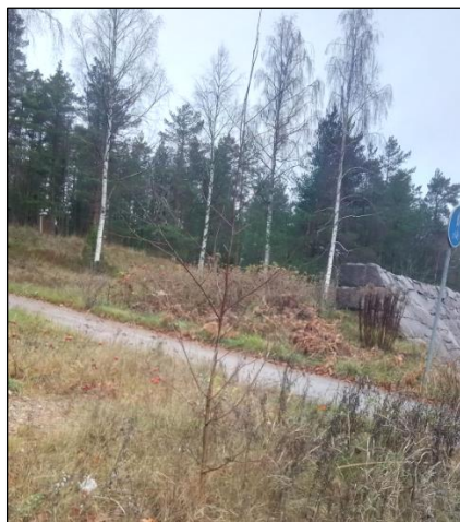
2020-11-24. Mur som utgjort stomme i blinderingsvall, inom befintlig avspärning. Mark i anslutning till f.d. blinderingsvall och kulfång ger intryck av att vara omgrävd.
