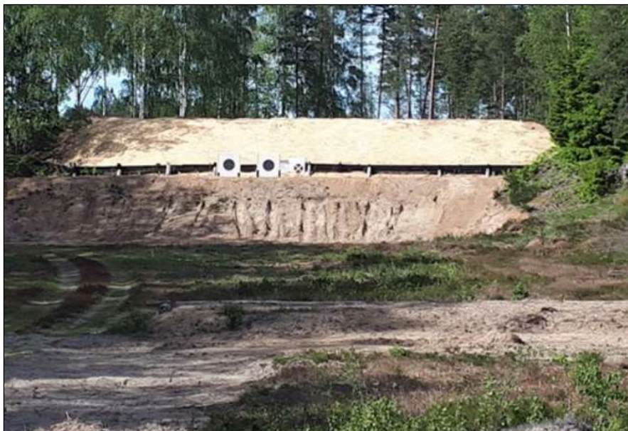
Figur 7. Blinderingsvall och kulfång på besiktad och godkänd 300-metersbana, Älmhults skytteförening. Bild från https://idrottonline.se/ , inlägget daterat 2020-07-03.
