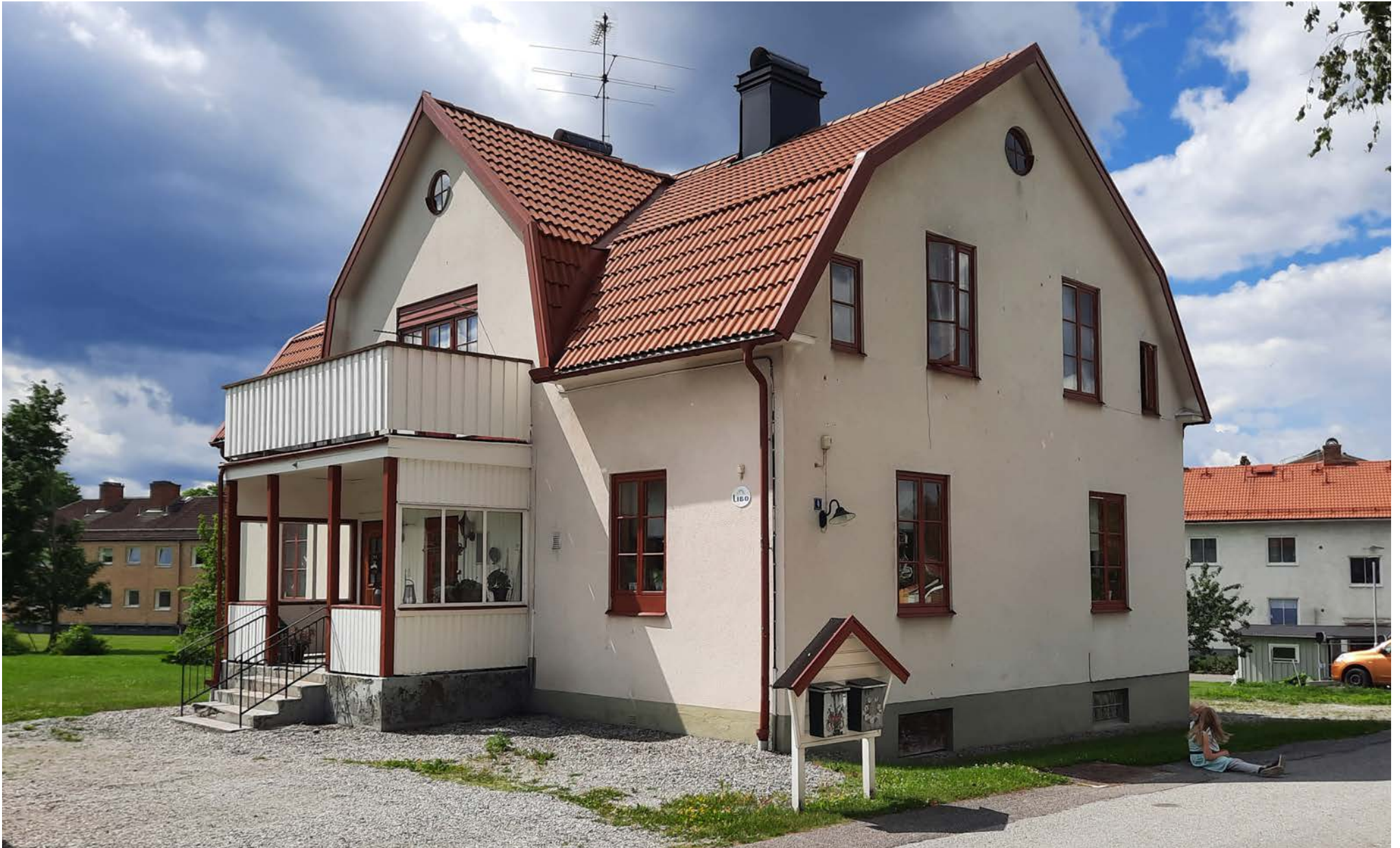
Entrésidan på huvudbyggnaden på Bågen 7, sedd från Kaplansgatan. Juni 2021.
