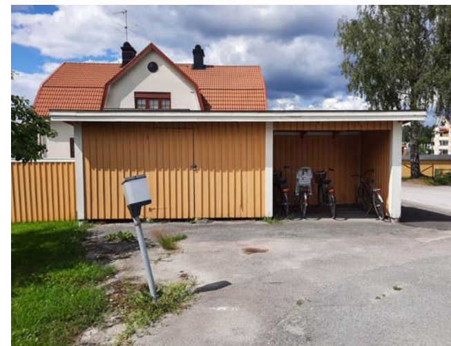
Överst: Baksidan sedd från Kaplansgatan. Underst: Komplementbyggnaden från 1980-tal.
